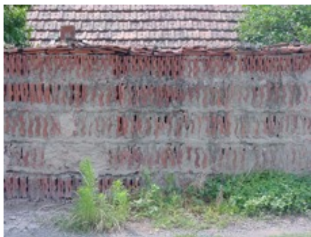
Murs séparatifs réalisés en tuiles de rebut
