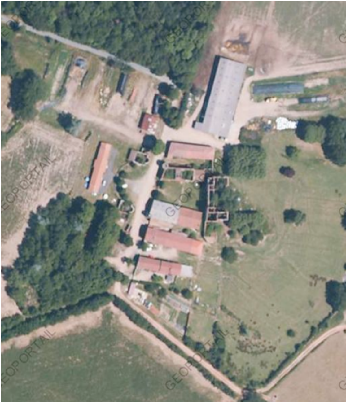
Vue aérienne du Château et de ses abords
