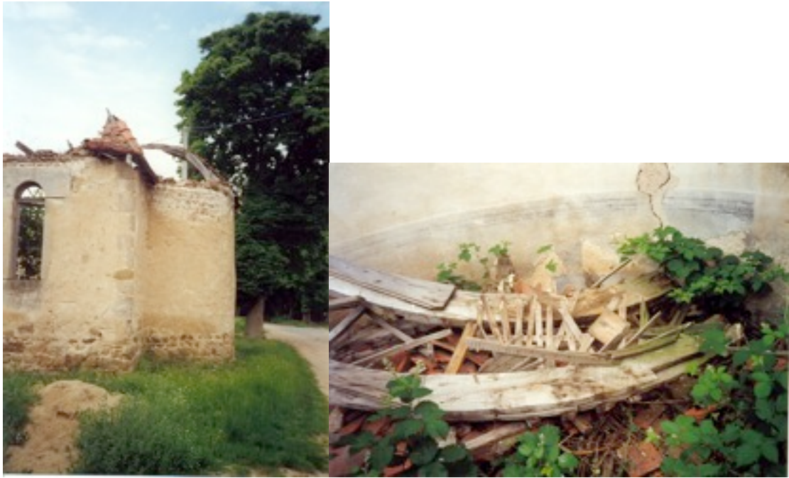
Pavillon - Charpente type Ph. Delorme (adaptée)
