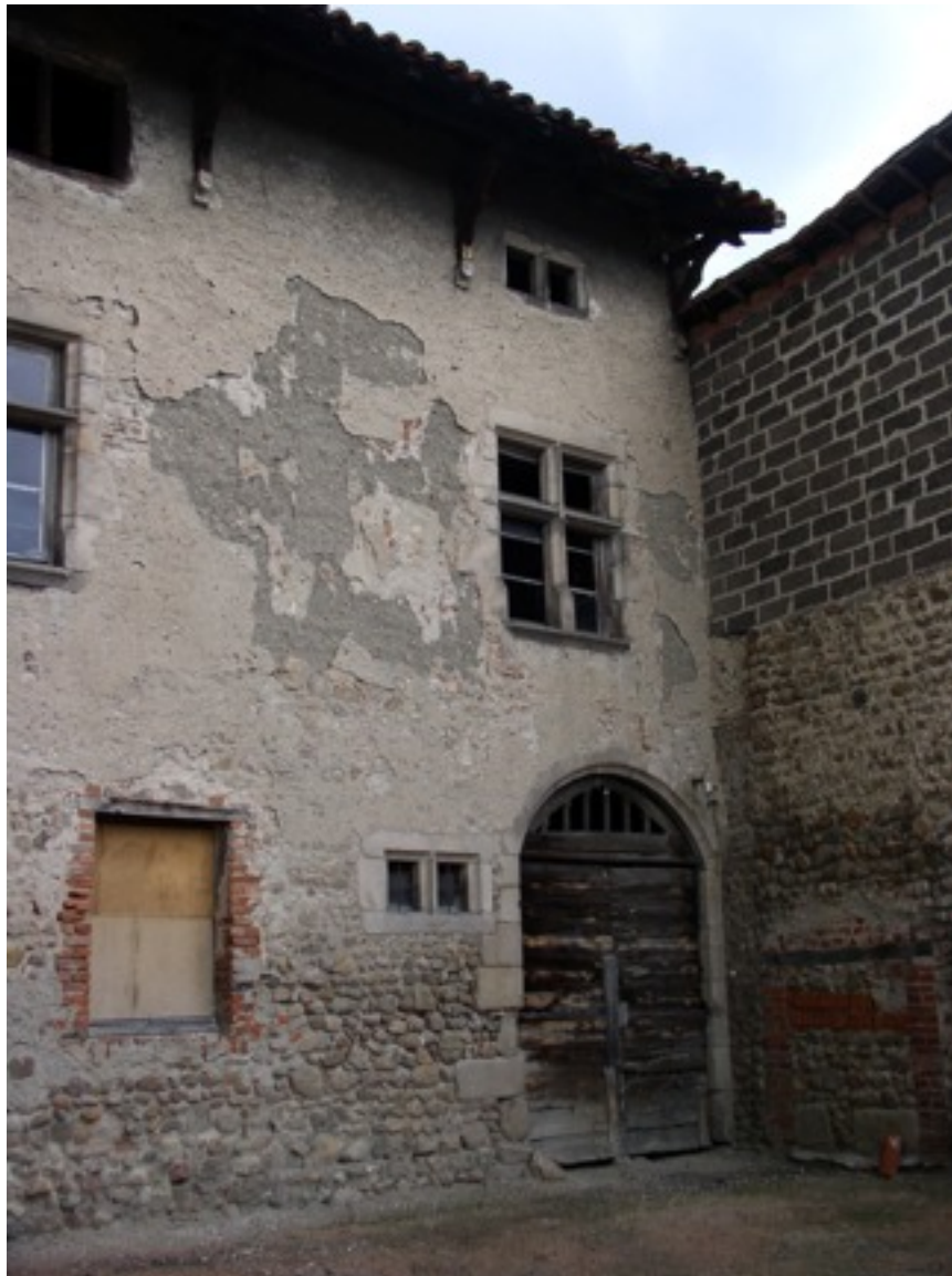
Grande élévation de la fin du XV e siècle : Assise en galet de granit, élévation en pisé et débords important de toiture
